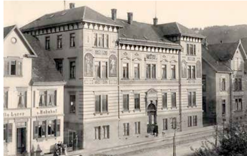
Fabrikgebäude Theodor Groz & Söhne in Albstadt, 1884
